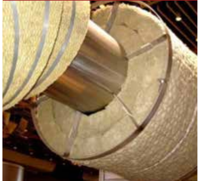
Теплоізоляція обладнання матеріалом Pro Wired Mat
